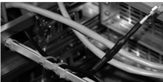
Рис. 8. Пример монтажа датчика температуры воздуха
